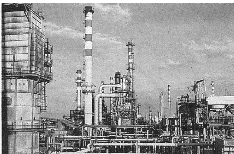
Falconara. Il progetto Api di una nuova centrale di energia è escluso dal Pear
